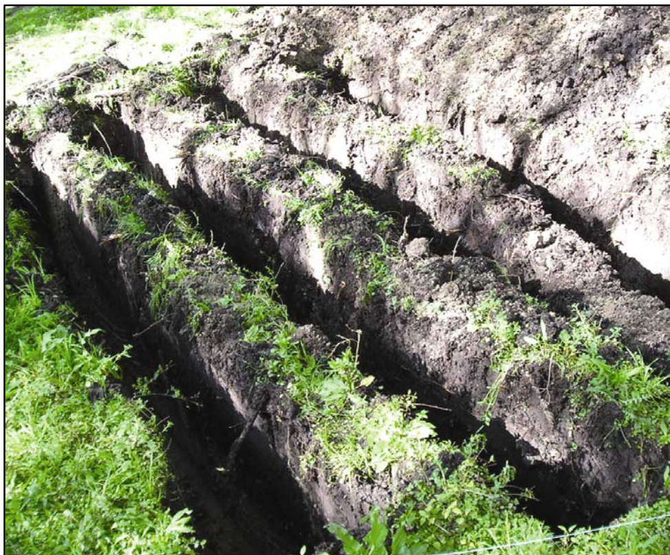
Figura 29. Trincheras realizadas en Zona Cañada Miguelete.
