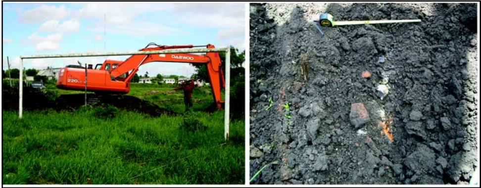
Figura 48. Excavación y pozo detrás de la línea del arco de fútbol hacia Peñarol.
