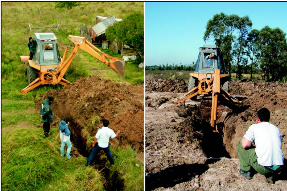
Figura 102. Vista parcial de las excavaciones a máquina efectuadas en las zonas J (izquierda) y D (derecha).
