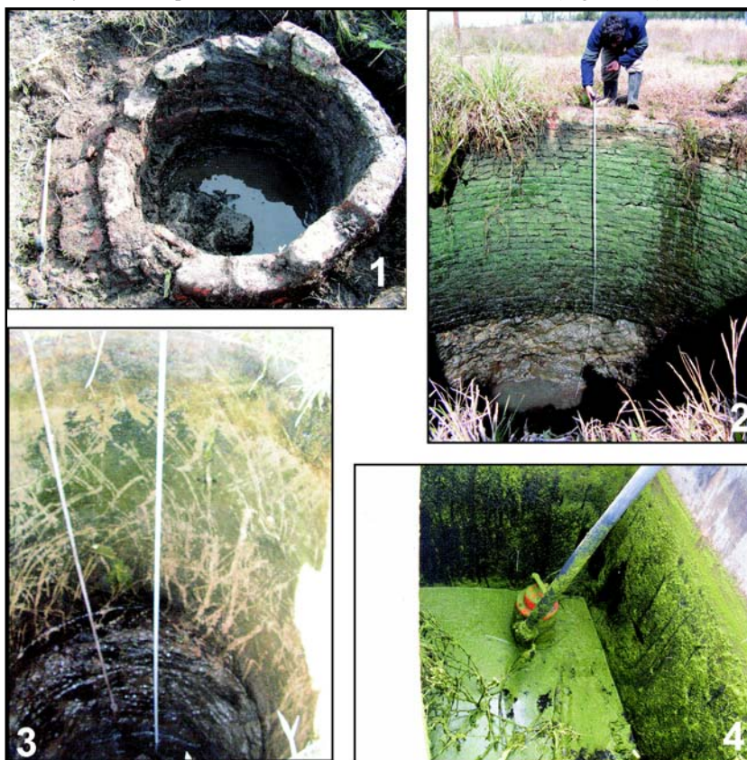
Figura 103. Pozos de agua vaciados. Los números de las fotografías corresponden a la numeración adjudicada a cada estructura.
