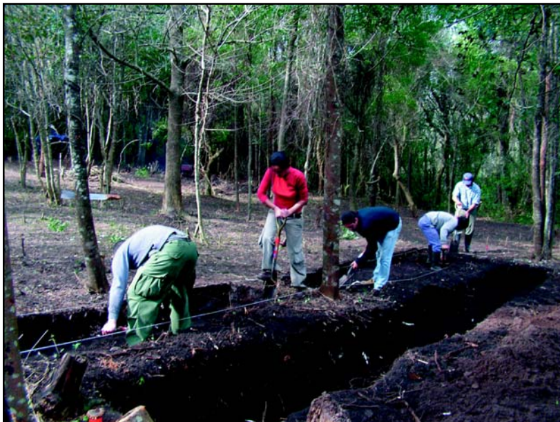
Figura 76. Excavación manual de las trincheras en el área abordada entre junio y julio de 2006.
