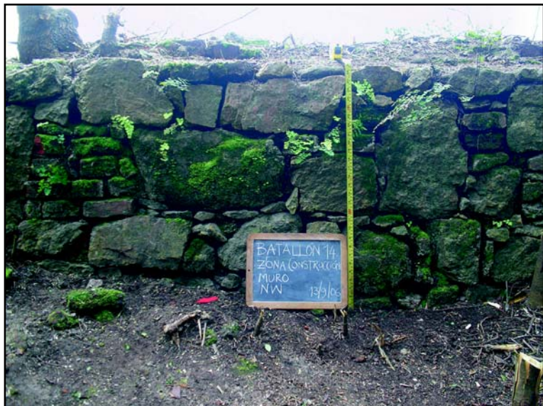
Figura 80. Detalle del sistema constructivo identificado. La flecha roja indica el Norte.
