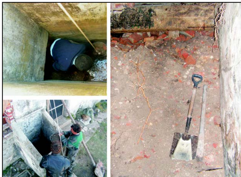
Figura 107. Vista interior de la habitación, donde se observa el material de relleno (derecha) y el trabajo de vaciado correspondiente (izquierda).
