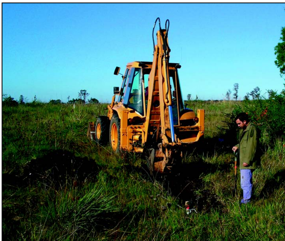
Figura 73. Vista de las excavaciones en el lugar señalado.
