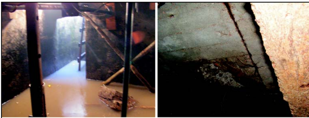
Figura 112. Aberturas a (izquierda) y b (derecha) vistas desde el interior de la cisterna.
