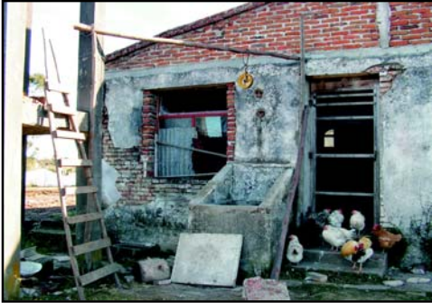
Figura 104. Abertura exterior que comunica con la pieza subterránea.
