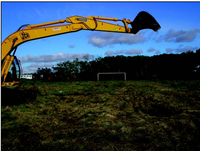
Figura 35. Inicio de las excavaciones en la línea media de la cancha de fútbol.
