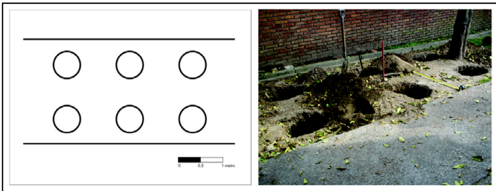
Figura 123. Dibujo de planta y foto de los pozos excavados para realización de parrillero.
