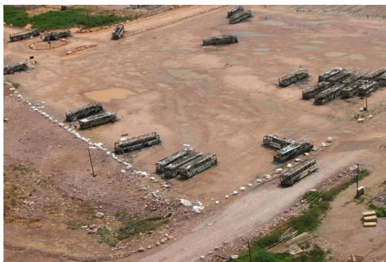
Foto 5 - Vista Geral acampamento em 18/03/2011
