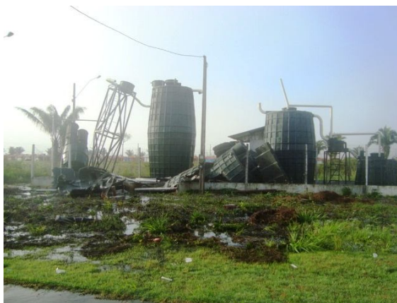
Foto – tanque de esgoto Mutum-Paraná
