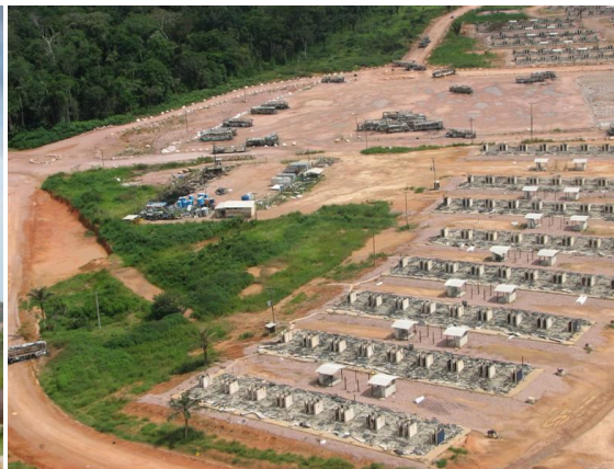
Foto 4 - Vista geral acampamento em 18/03
